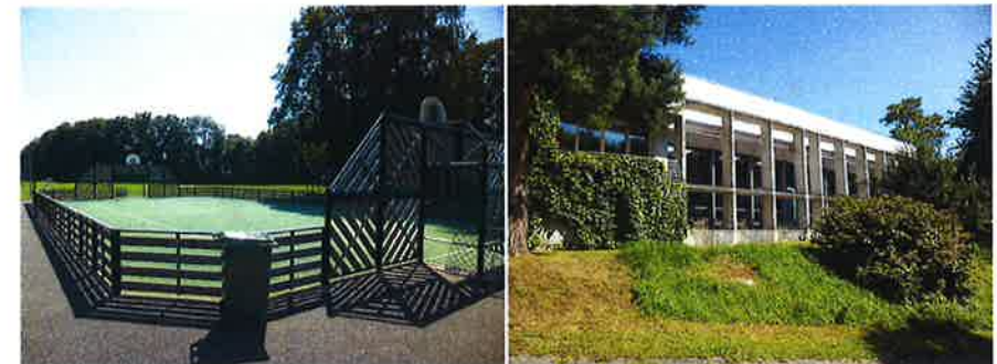
Les infrastructures sportives de la Commune : Terrain multisports (à gauche) et salle de sport (à droite).
