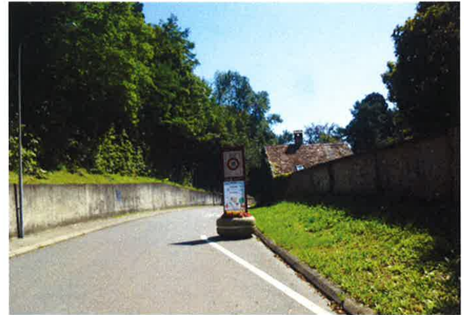
Rétrécissement latéral à l'entrée de la zone 30km/h, chemin de Mézery
