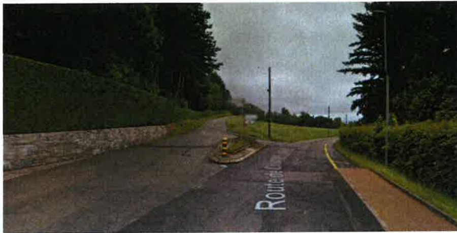
Figure 4 – Carrefour Champvent-Fleur-de-Lys amont (Source : Google)
