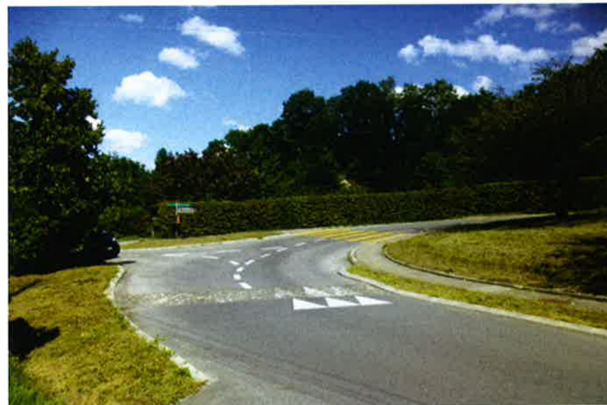
Décrochement vertical, chemin du Lussex
